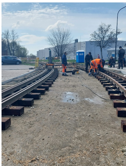
Remont przejazdu kolejowego 700 - lecia
