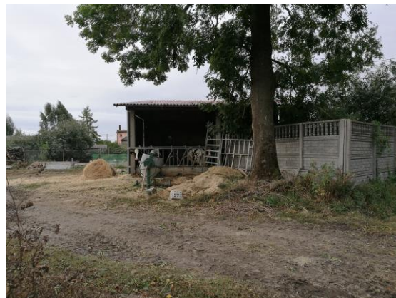
Fot.8 Budynek inwentarski(wiata)na działce nr 78
