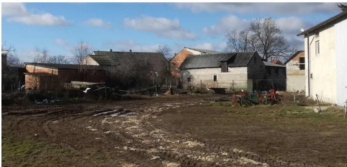
Fot.3 Podwórze gospodarcze od strony północno-wschodniej. W głębi budynki inwentarskie i gospodarcze.
