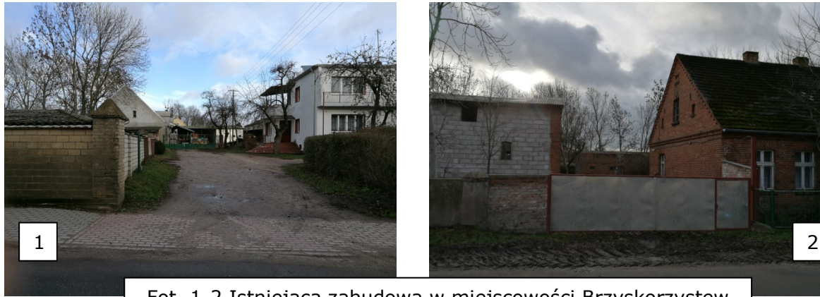
Fot. 1-2 Istniejąca zabudowa w miejscowości Brzyskorzystew
