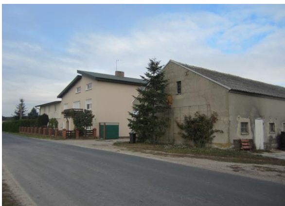
Fot.2. Zabudowa mieszkaniowa i inwentarska przy drodze powiatowej DP-2304C
