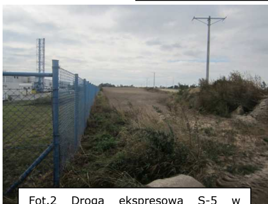
Fot.2 Droga ekspresowa S-5 w budowie po zachodniej stronie
