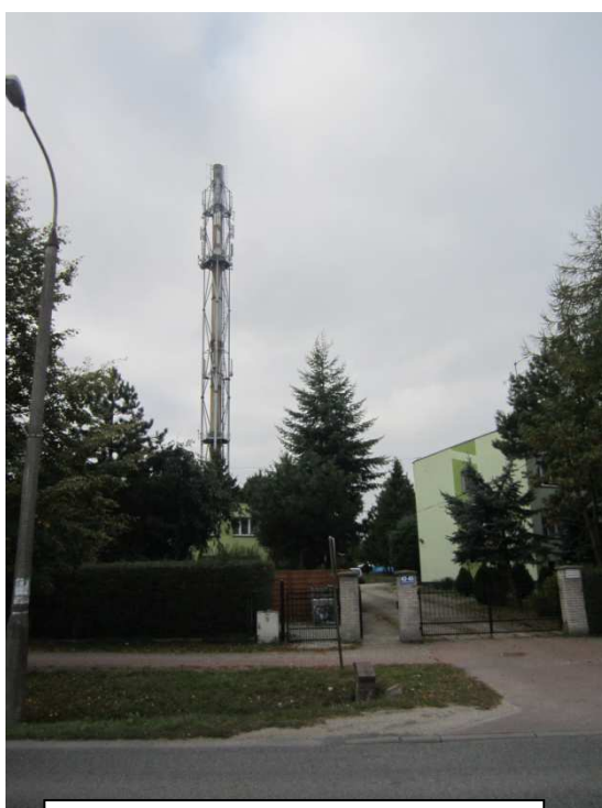
Fot.9 Komin wykorzystywany jako podpora anteny nadawczej radia
