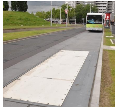
Fotografia 4 – Ładowanie indukcyjne – odbywa się poprzez umieszczoną w nawierzchni płytę i odbiornik wewnątrz autobusu.
