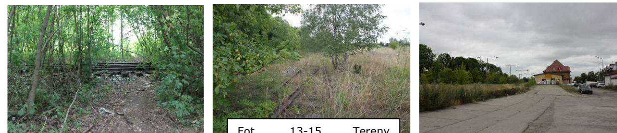
Fot. 13-15 Tereny nieczynnej linii kolejowej
